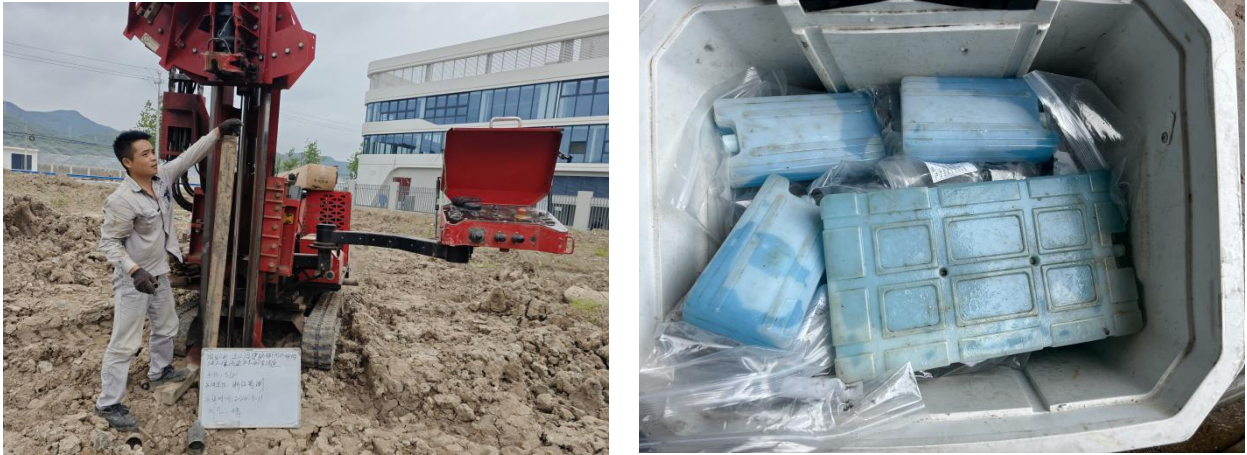
图5.2.2-1 一次采样部分土孔钻探及土壤样品照片
